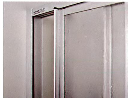
Durch Ausgleichprofile kann die Gleittür bis zu 50 mm verbreitert werden. Nicht lotgerechte Wände sind somit sauber anzupassen.
